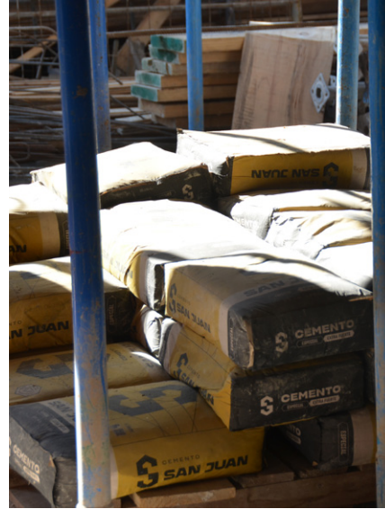
[Fig. 54] Carretilla [Fig. 55] Carretilla [Fig. 56] Kilos de cemento
