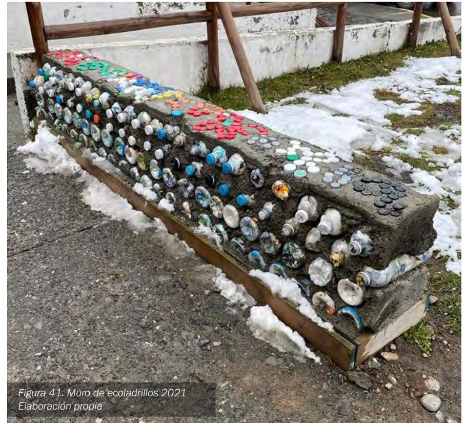
Figura 41. Muro de ecoladrillos 2021
