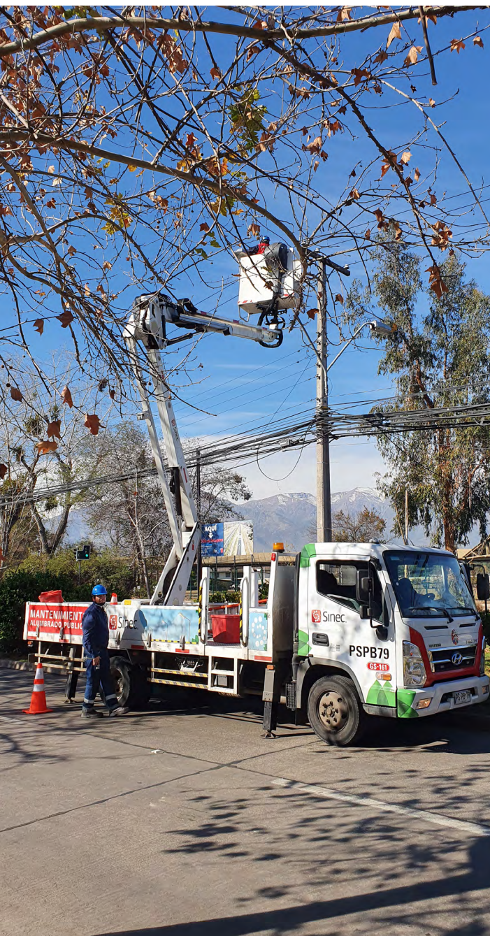
Fig. 51: Mantención de luminarias adosadas a un poste por la empresa Sinec en la comuna de Vitacura.
