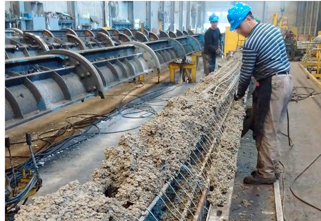
Fig. 55: Proceso de llenado de la matricería con concreto (Utility Structures Inc., n.d.).
