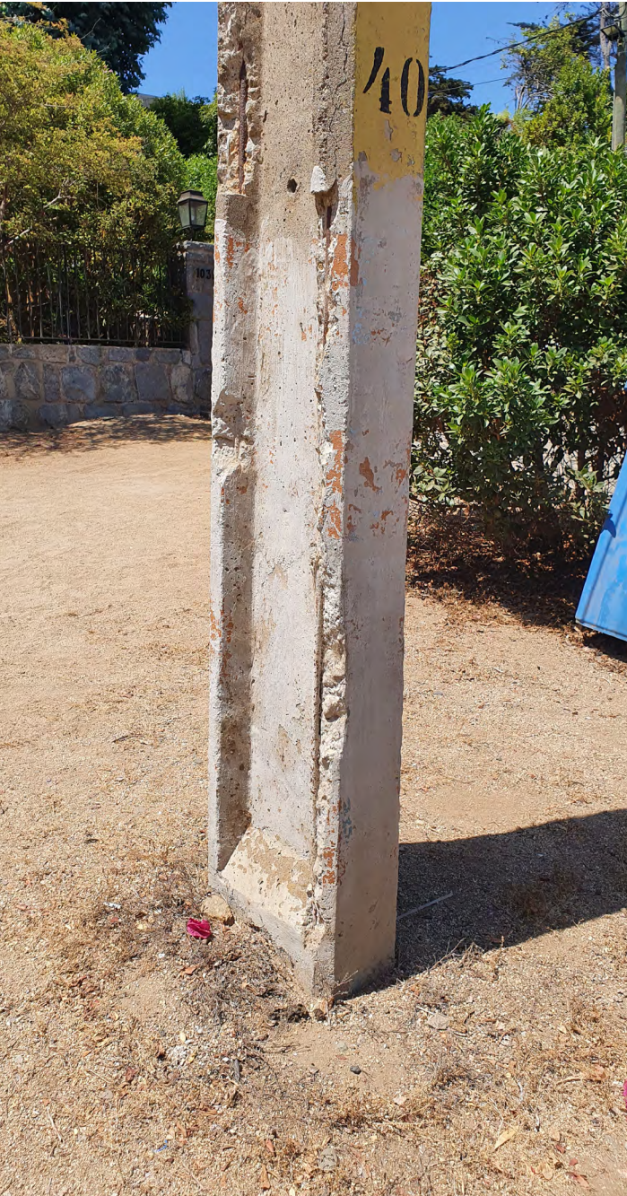
Fig. 36: Poste de la Región de Valparaíso que presenta degradación en varias alturas, tal vez debido a la penetración de cloruro.
