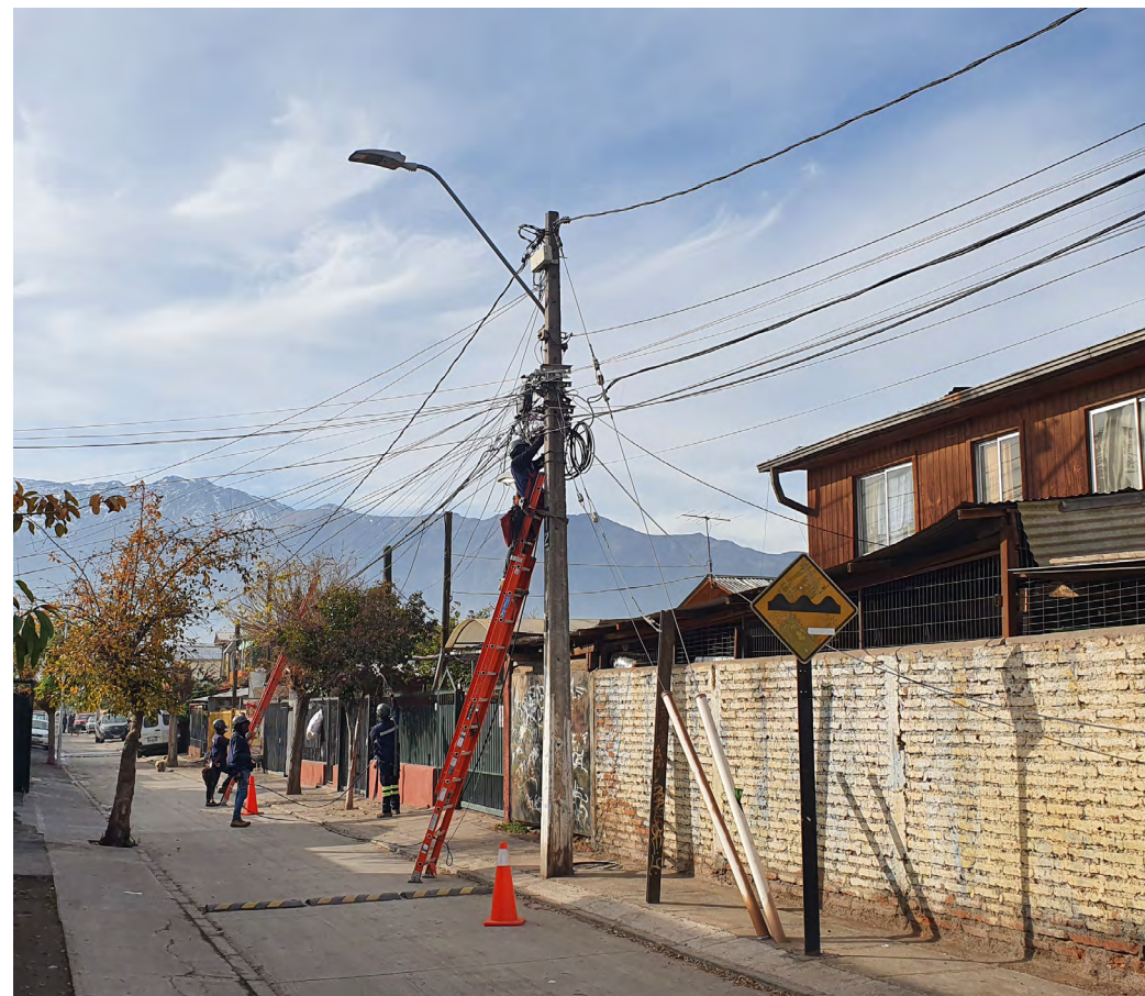
Fig. 50: Instalación de nuevo cableado de baja tensión en la comuna de Macul.
