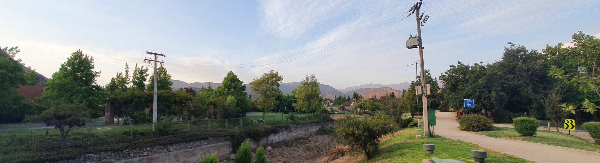
Fig. 10: Uso de postes en una zona de líneas soterradas en Santiago, debido a la presencia de un arroyo.
