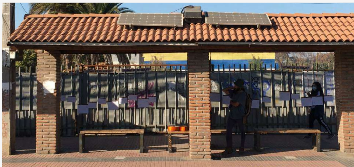
Fotografía Intervención 4. Primer módulo del paradero.
