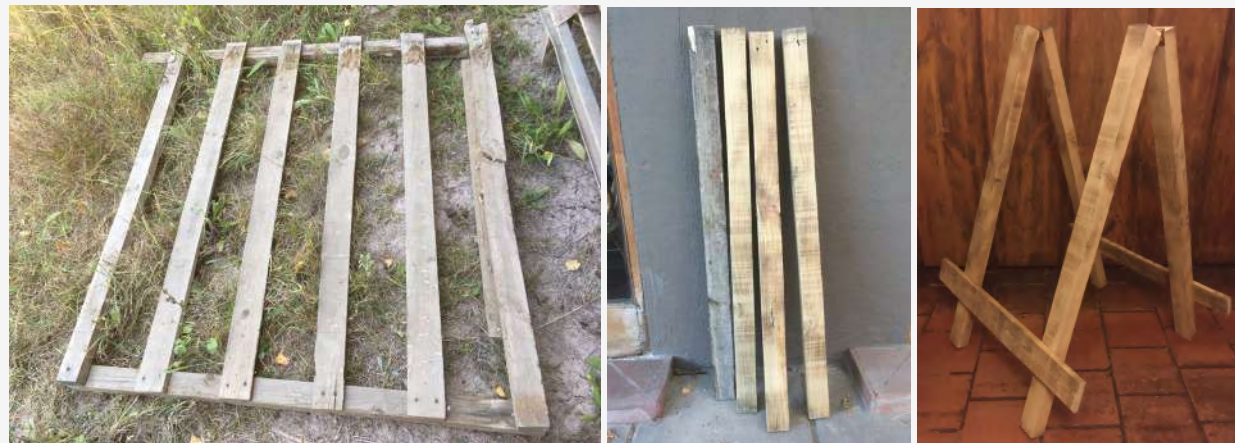
Imagen 43: Proceso de construcción, caballete soporte colectivo.
