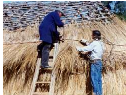
figura 2,3 & 4 Construcción de ruka en el museo mapuche de cañete, a la usanza tradicional. fuentes o autor: Museo Mapuche de Cañete, Colección digital.
