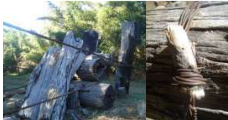
Figura 17: Sistema de anclaje y tensión de carritos de río al interior de San Fabián de Alico
