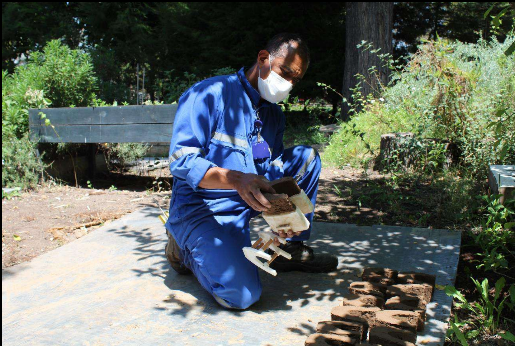
Don Guillermo, desmoldando el bloque constructivo
