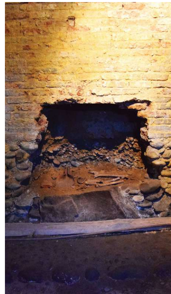
Zona de excavación. Túnel de los Carrera, El Monte.
