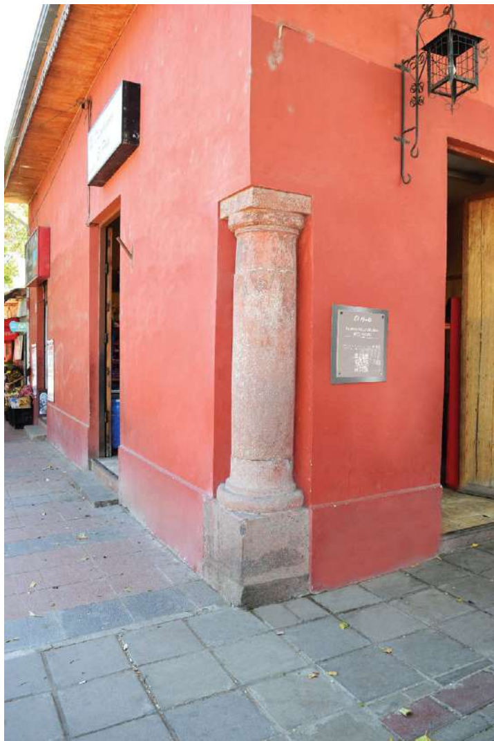
Placa QR instalada en uno de los pilares de la colonia.
