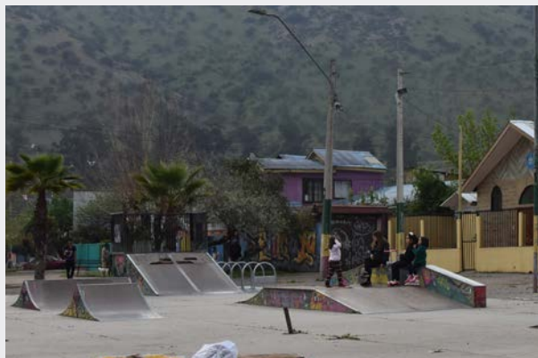
Antes de la reparación
