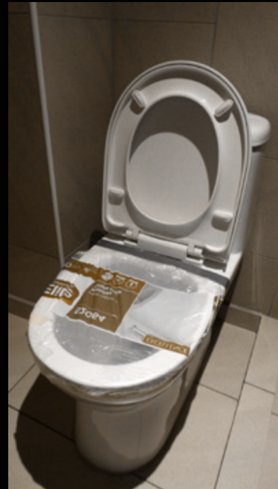
Cubrir inodoro con bolsas plásticas, desagüe con cinta adhesiva y muro (poniente) con cajas tetra-pack
