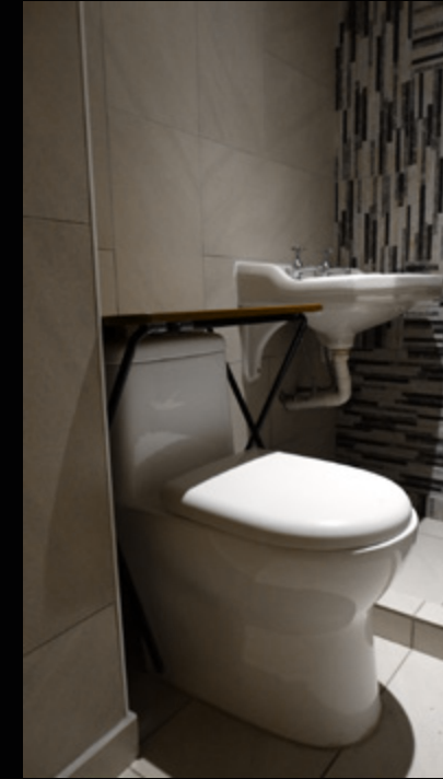
Montar mesa(1) de trabajo sobre estanque de inodoro.
