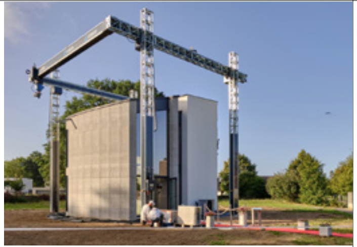
KAMP C CONSTRUYO UN PROTOTIPO DE VIVIENDA IMPRESA EN 3D DE DOS PISOS USANDO UN IMPRESORA DE 10M X 10M EN AMBERES, BELGICA, 2020.
