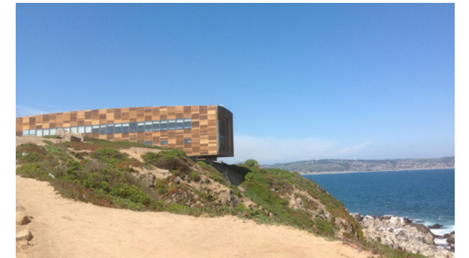
Edificio de la Estación Costera de Investigaciones Marinas.
