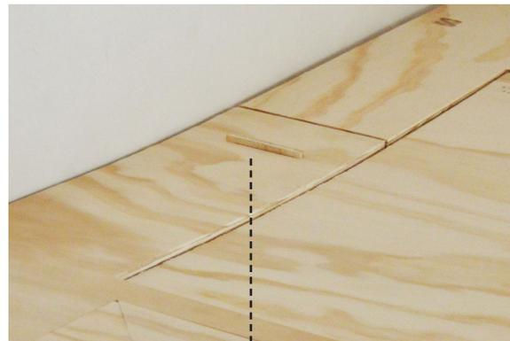
*Pieza con forma de T, permite mantener firme las dos piezas con forma de L.*
