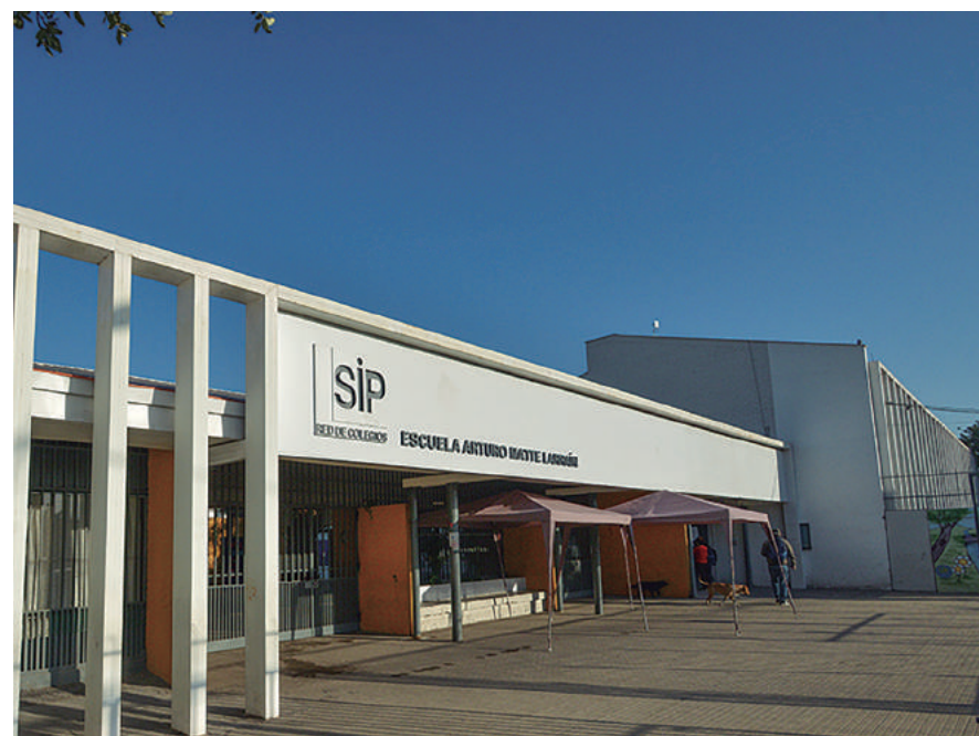
► Fotografía de la infraestructura del establecimiento.
