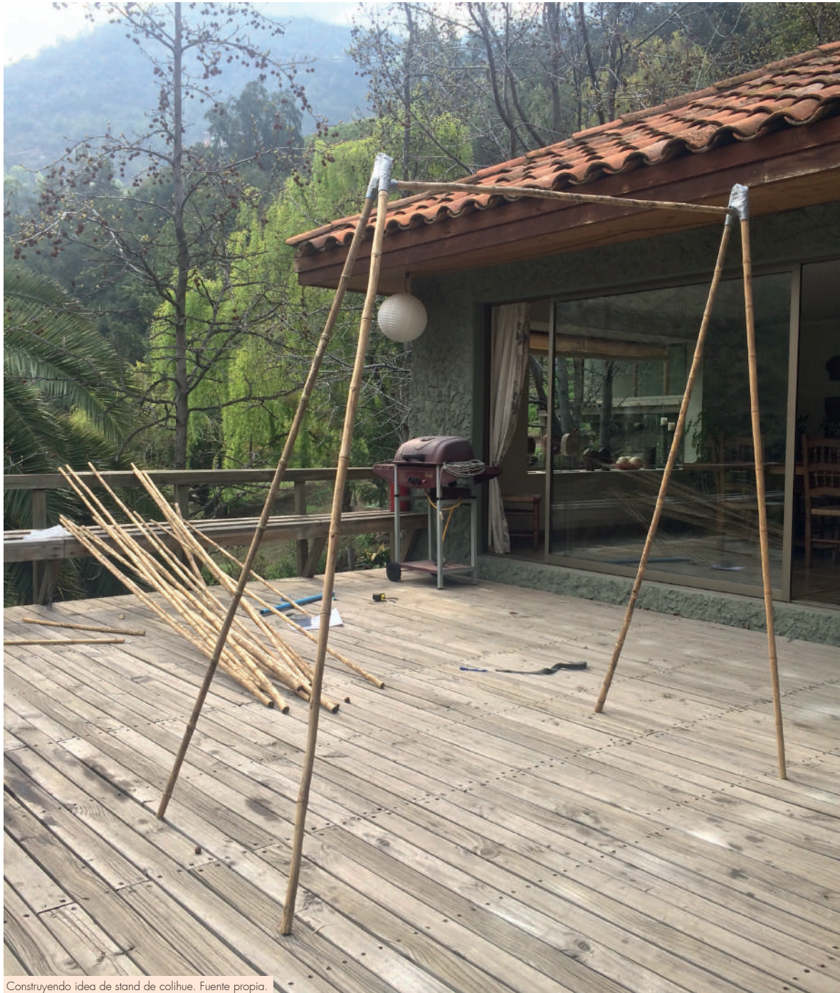
Construyendo idea de stand de colihue. Fuente propia.
