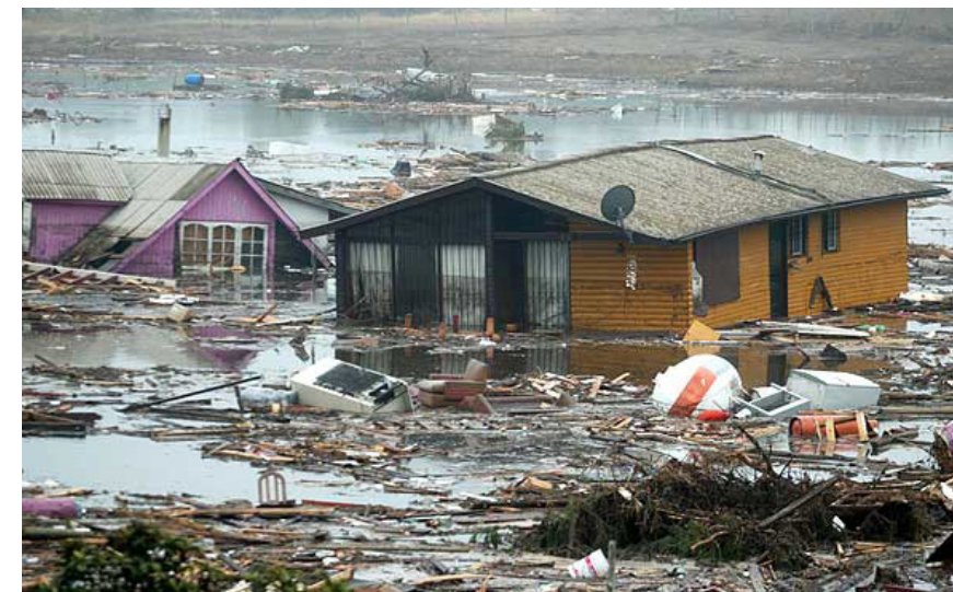
Imágenes Efectos del terremoto y tsunami de 2010 en Chile.
