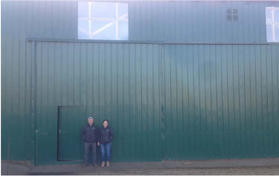
Vista exterior del galpón
