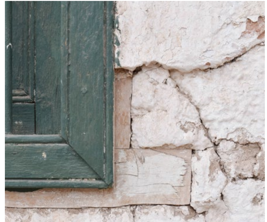
Detalle de marco de ventana en Socoroma. Elaboración propia.
