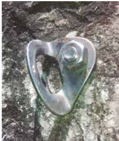
CHAPA INSTALADA MECÁNICAMENTE
