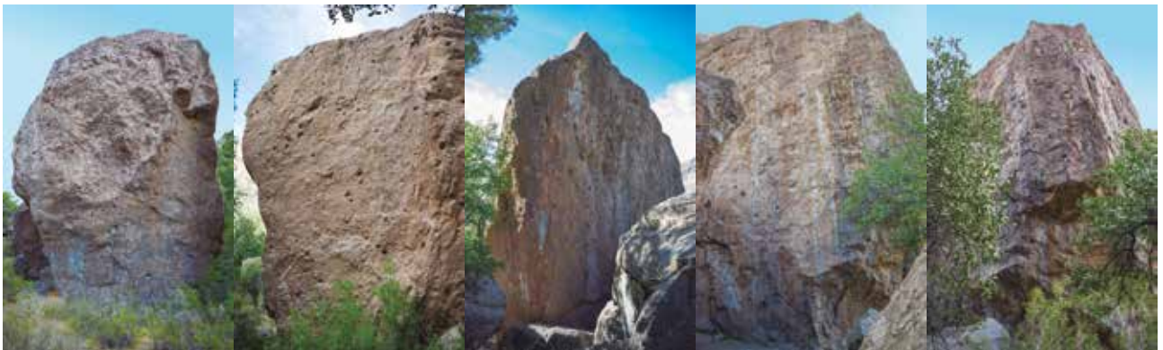
Pared Noreste, Pared Oeste, Pared Suroeste, Pared Sureste, Pared Este de la subzona Gran Monolito.
