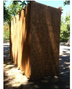
El largo de la estructura de 354cm forzaba a cortar la última plancha 12cm para el calce exacto del módulo. Con las planchas ya modificadas, se procedió a su instalación con tornillos, lo que se tradujo en la rigidización efectiva de la construcción.
