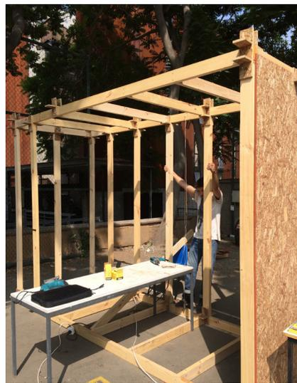
El paso siguiente consistió en la instalación de los pilares principales, los cuales fueron modulados a una distancia de 122cm utilizando un nivel de agua. Luego se agregaron los pilares y cadenas intermedios modulados a 60cm. Teniendo la estructura de vigas y pilares armada, se probó su resistencia, tanto en la
