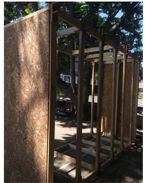
impidiendo su deformación. Gracias al carácter "perfectible", propio de los sistemas capaces de repararse cambiando sus piezas como bicicletas o autos, se pudo ir reajustando y Diseñando en el proceso. Los nudos del pilar intermedio de la cara ancha del módulo, obligaba a cortar las planchas, proceso que repetido en X cantidad de módulo
