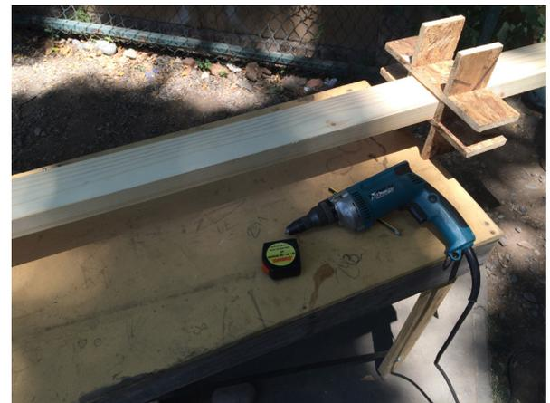
Para la construcción de los NUDOS # se utilizaron planchas de OSB de 1,5cm de espesor, que primero fueron cortadas en la sierra de pared en tablones de 19,5cm, 25,5cm y 30cm. Luego los tablones fueron cortados en la sierra de mesa a 9cm, que se relaciona al ancho del palo de 2"x4" pulgadas o 4,1 x 9 centímetros. Por último se pusieron topes a medida en la ingleteadora para debastar las
