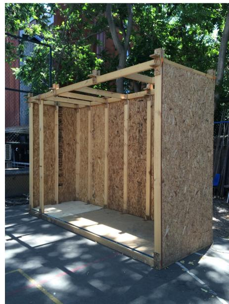
Por último, se midió el espacio faltante del piso para luego cortar una plancha con sus medidas. Hay que ser muy rigurosos con el corte de los calces ya que estos en pocas ocasiones se ajustaron con precisión [podría corregirse con una guía pre Diseñada].
