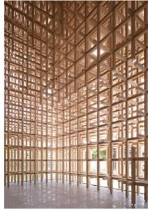
*Unión Mecánica Ensamblada : "Junta que por la geometría de sus partes constitutivas esenciales se mantiene estructuralmente estable. Unas a otras, las partes llenan los vacíos propios de sus geometrías, impidiéndose mutuamente cualquier movimiento imprevisto"*
