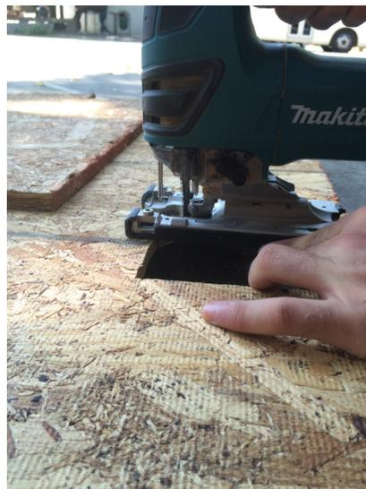
Para la instalación del suelo se utilizó una placa de madera terciada estructural de 20mm. El sistema tiene la desventaja de tener que cortar las placas en la junta con el nudo, esto se debe al espesor que queda libre en las alas de éste. Aquí se entendió que el espesor del nudo debe ser igual a la placa del
