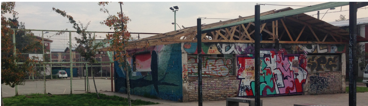
Imagen. Fotografía del estado actual del exterior e interior de la Sede Liberada.
