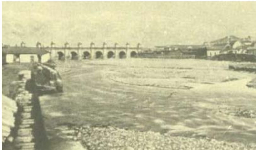
Puente Cal y Canto antes de la canalización del río Mapocho, 1888
