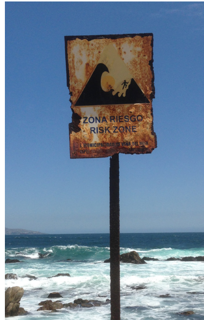
Mala mantención: material corroído. No son visibles en la noche.
