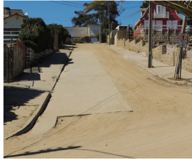
Dificultad evacuación peatonal para personas con movilidad reducida.
