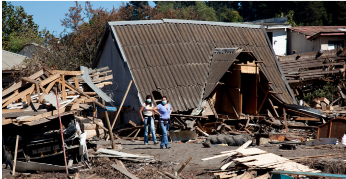
Restos de construcción en Constitución, Chile 2010. Foto por: Wilson Hunter recuperada de www.flickr.com , 2015
